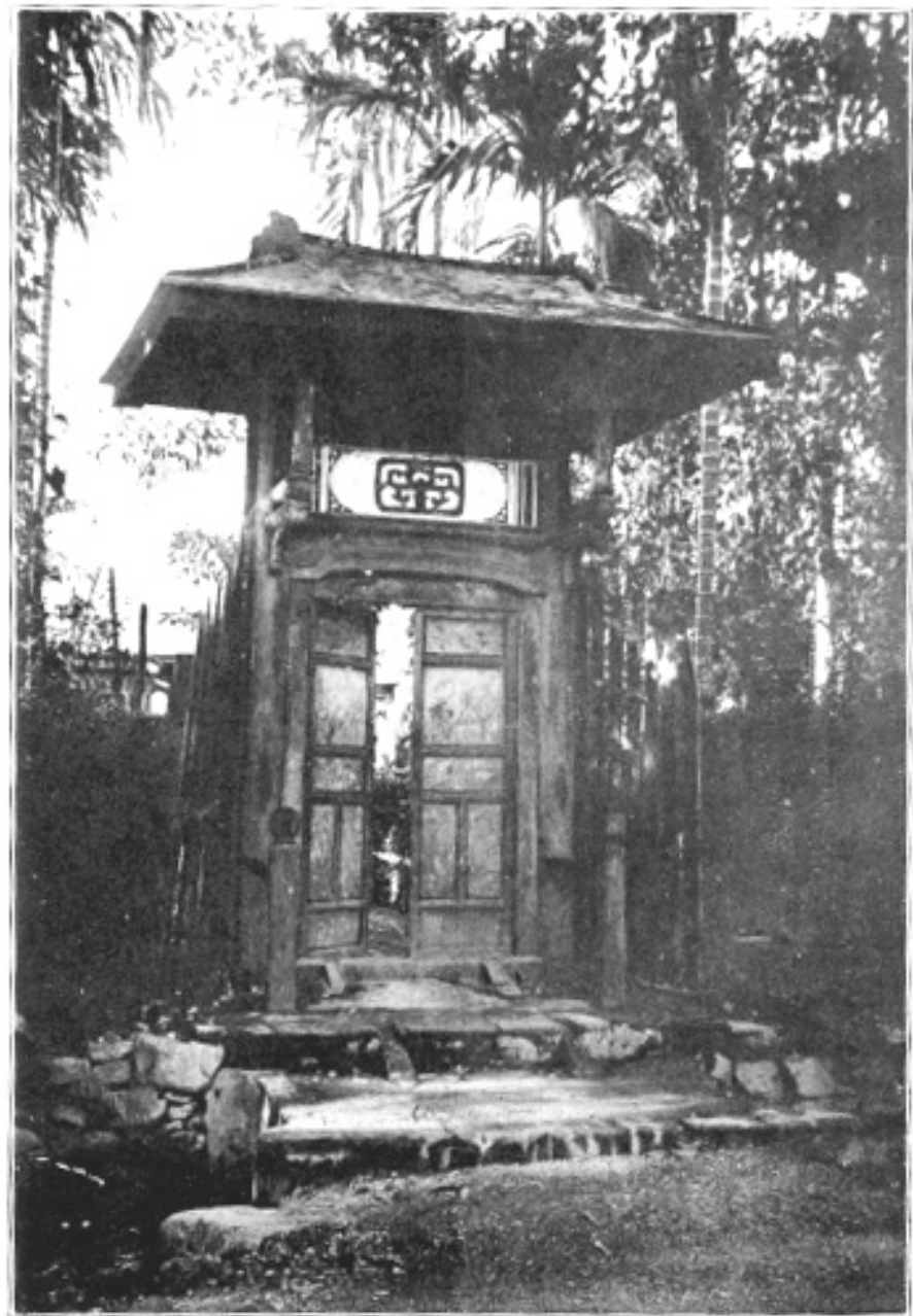
Planche LXXIII. — Portail annamite, dans le quartier des fonderies de canons
